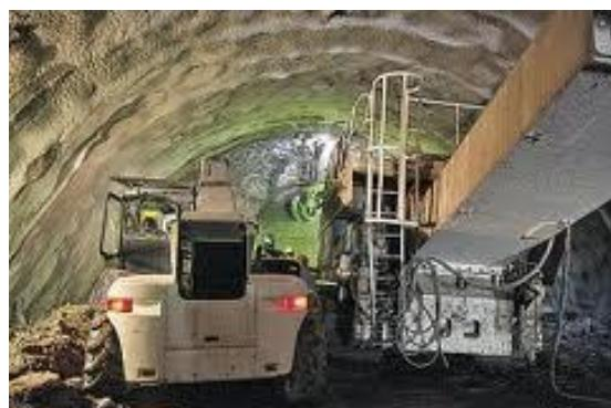
*Şəkil 2.40. Dağ qazmalarının bağlanıb bərkidilməsi üçün maşın*
