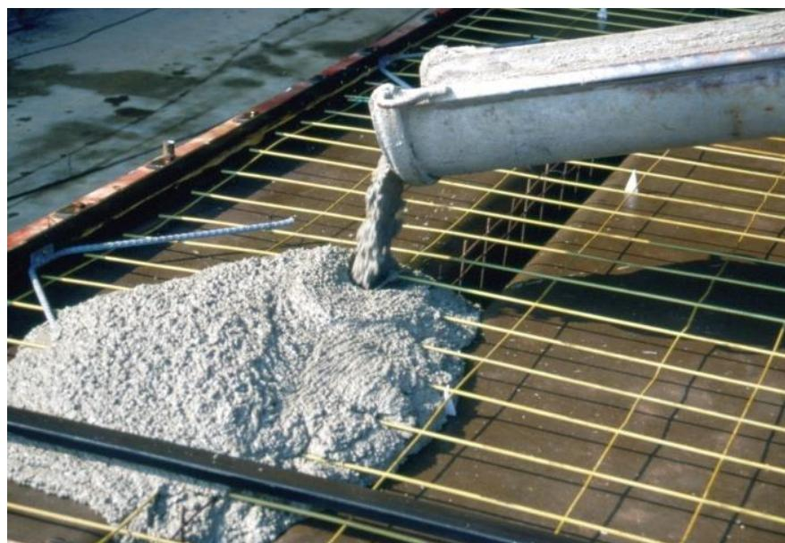
**Səkil 1.19.** Dəmir-betonun hazırlanması
