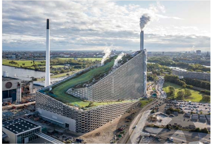
▲ C. Amager Bakke elektrik stansiyası
