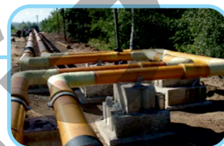
Рис. 5.4. Расширение твердого тела при нагревании и сжатие при охлаждении
