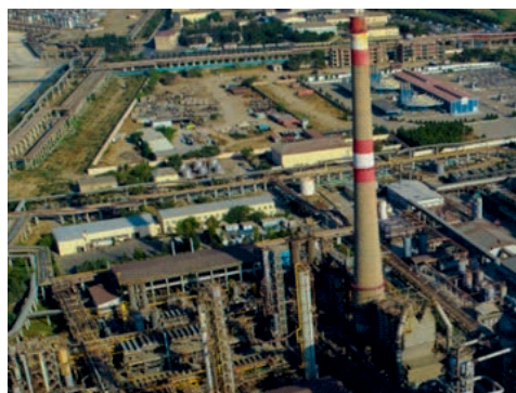
Установка каталитического крекинга на нефтеперерабатывающем заводе
