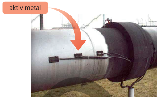
Aktiv metal polad borunu korroziyadan qoruyur
