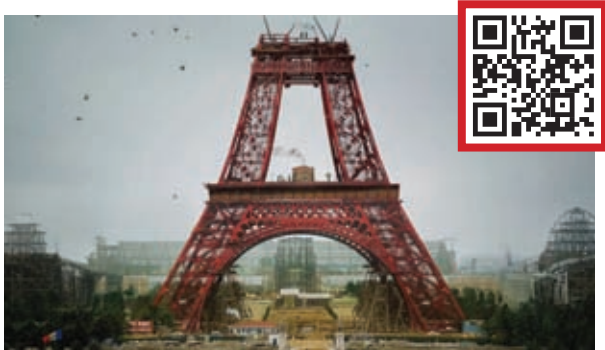
Строительство Эйфелевой башни
