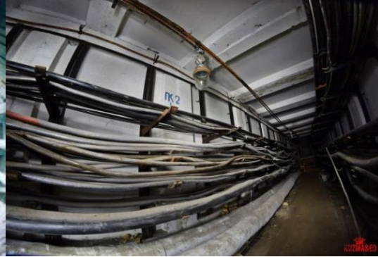
Şəkil 3.5. Kabellərin kollektorlarda çəkilişi
