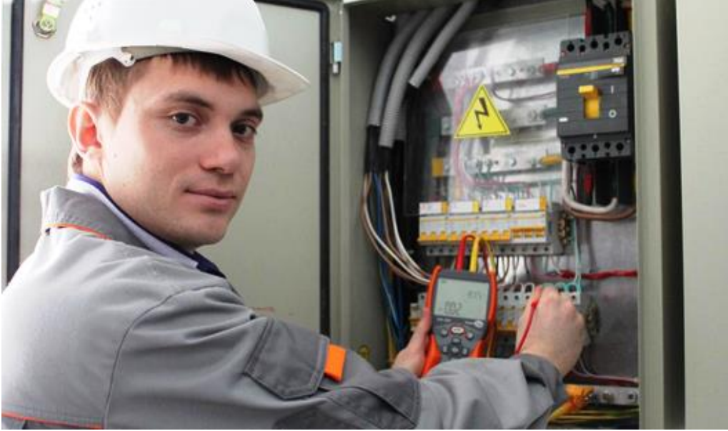
Şəkil 3.17. Elektrik şəbəkəsinin yoxlanması
