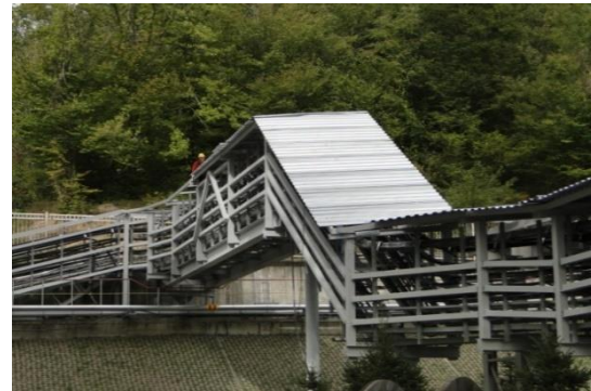
Şəkil 3.6. Kabellərin qalereya və estakadalarda çəkilişi
