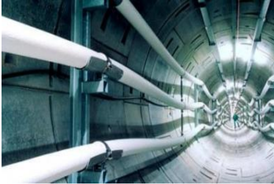
Şəkil 3.4. Kabellərin tuneldə çəkilişi
