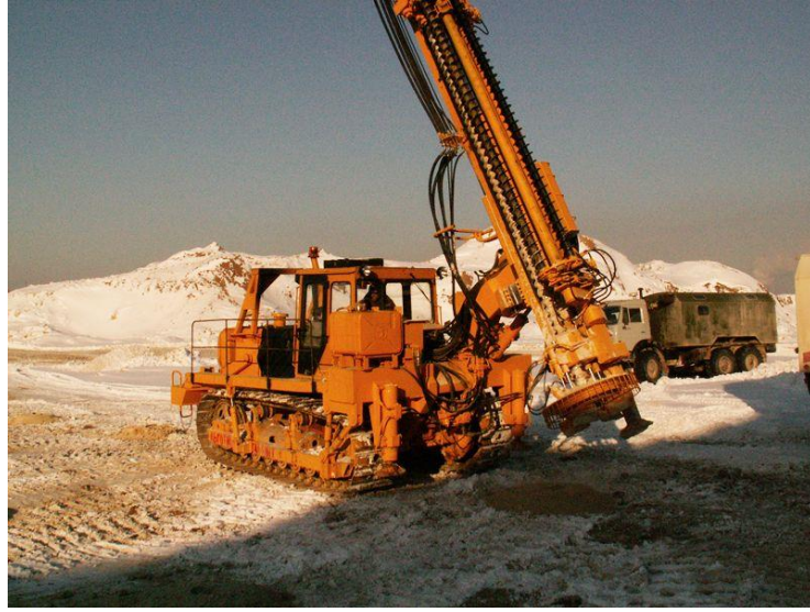
Şəkil 4.8. CBP-160 qazma dəzgahı
