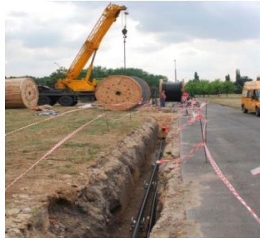
Şəkil 3.1. Kabellərin xəndəkdə çəkilişi
