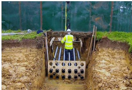
Şəkil 3.2. Kabellərin blokda çəkilişi
