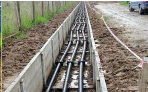
Şəkil 3.3. Kabellərin kanalda çəkilişi
