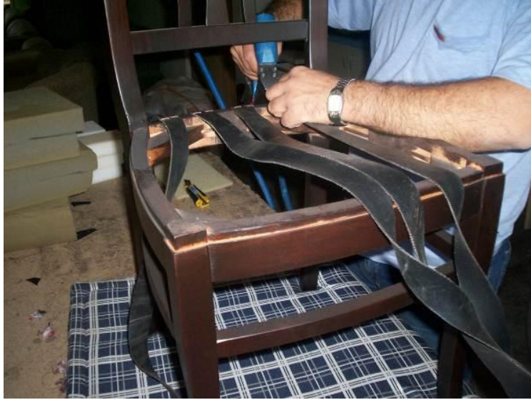
Şəkil 4.40. Bantın çıxmayan oturacaq çərçivəsinə bərkidilməsi
