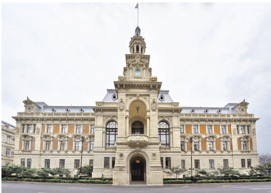
Bakı şəhər Dumasının binası (müasir görünüşü)
