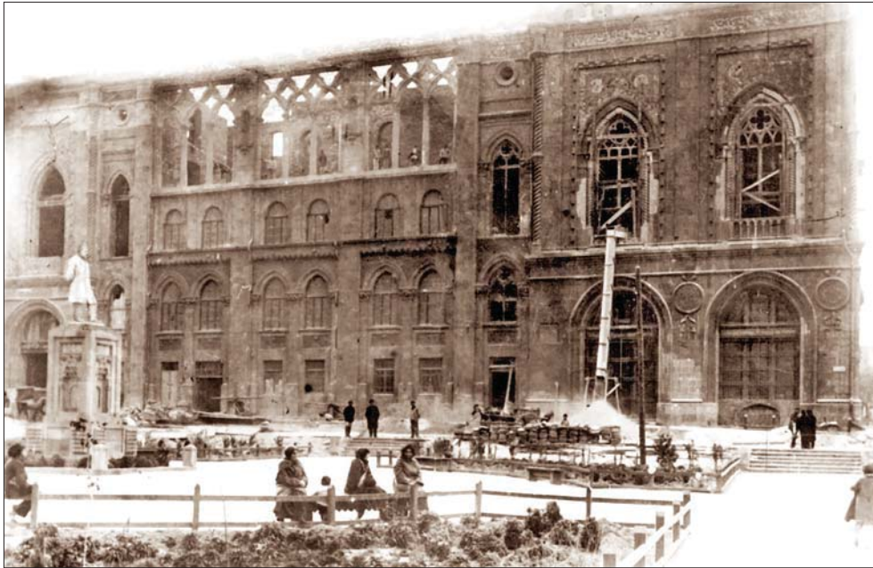
Müsəlman xeyriyyə cəmiyyəti binasının — «İsmailiyyə»nin (Hazırda AMEA-nın Rəyasət heyətinin binası) Mart soyqırımından sonrakı görünüşü
