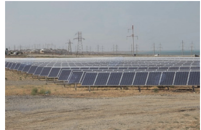
(b) Helioelektrik stansiyası. Sumqayıt.
