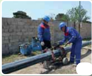
Su borularının təmiri
