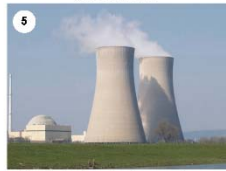
Elektrik stansiyalarının inşası
