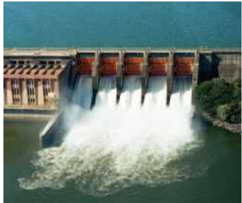
Su elektrik stansiyası (suyun mexaniki enerjisi)
