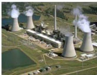
Atom Elektrik Stansiyası
