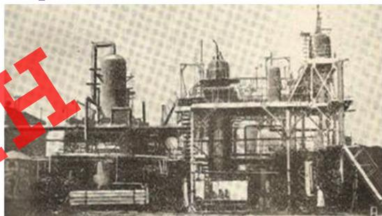
“Установка по термохимическому смягчению морской воды”, впервые в мире построенная в Баку для парового котла электростанции. Баку, 1902 г.
