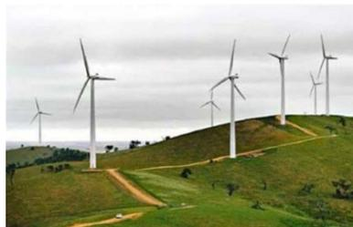
**Ветровые электростанции** вырабатывают энергию от воздушных потоков. Одна турбина (ветрогенератор) может производить электроэнергию для 600–800 домов. Для нормальной работы такой электростанции необходимым условием является наличие ветра со среднегодовой скоростью 4,5 м/с. Электроэнергия ветра имеет большую долю в топливно-энергетическом балансе Дании, Нидерланд. Прогнозируется, что доля ветровой энергии в топливно-энергетическом балансе Азербайджана составит 4,5 ГВт.
