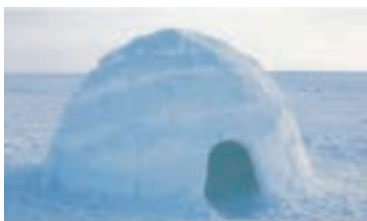
Иглу – традиционное жилище эскимосов в Северной Америке, построенное из льда. Внутри иглу утепляют шкурами животных.
