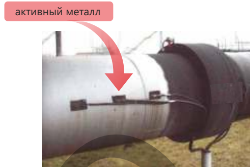
Активный металл защищает трубу от коррозии
