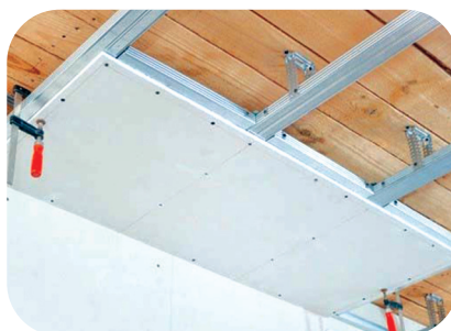
Рис. 8. Прикрепление листов гипсокартона
