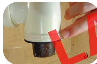
Рис. 7. Технология механической чистки сифона
