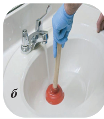
Рис. 6. Механическая чистка сифона вантузом: а – вантуз; б – чистка сифона вантузом
