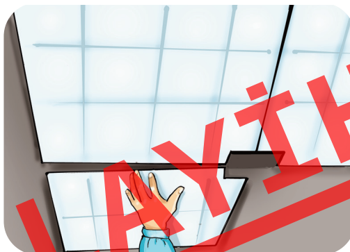
Рис. 3. Наклеивание плит к потолку
