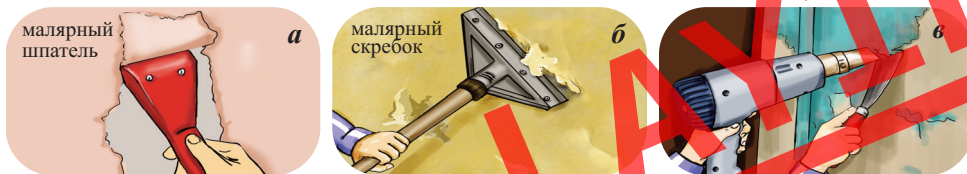
Рис. 1. Способы удаления красок: а, б – механический; в – термический
