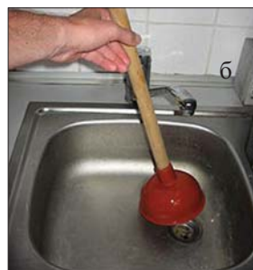
Рис. 6. Механическая чистка сифона вантузом: а – вантуз; б – чистка сифона вантузом
