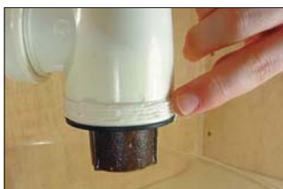
Рис. 7. Технология механической чистки сифона
