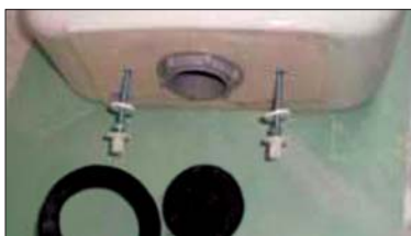
Рис. 3. Замена болтов крепления бачка
