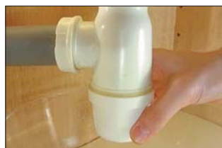
Рис. 7. Технология механической чистки сифона
