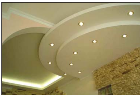
Рис. 6. Подвесной потолок с подсветкой из гипсокартона
