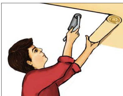
Рис. 2. Наклеивание обоев на потолок
