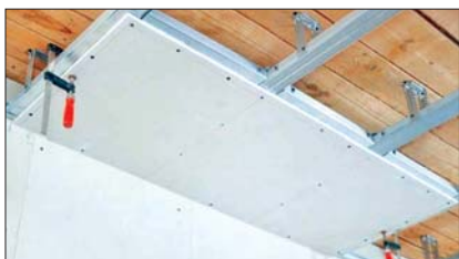
Рис. 8. Прикрепление листов гипсокартона
