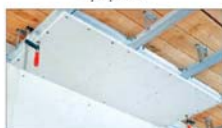
Рис. 8. Прикрепление листов гипсокартона
