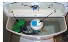
Рис. 2. Основные функциональные части сливного бачка: а – впускная (наполнительная) арматура; б – спускной механизм; в – кнопка слива воды
