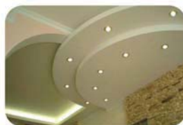
Рис. 6. Подвесной потолок с подсветкой из гипсокартона
