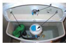
Рис. 2. Основные функциональные части сливного бачка: а – впускная (наполнительная) арматура; б – спускной механизм; в – кнопка слива воды
