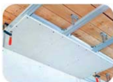
Рис. 8. Прикрепление листов гипсокартона
