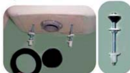
Рис. 3. Замена болтов крепления бачка
