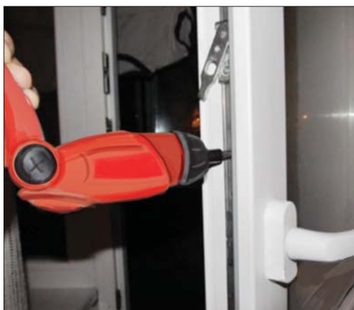
Рис. 6. Снятие фурнитуры
