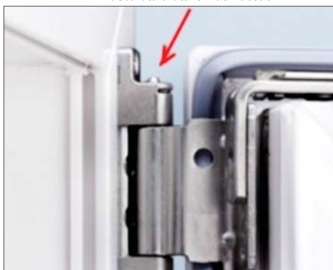
Рис. 4. Вынимание оси из петли
