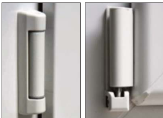
Рис. 3. Снятие декоративного колпачка с петель
