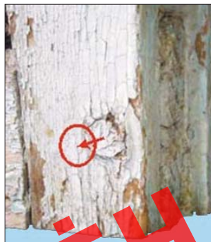
Рис. 5. Скрепление окна нагелем
