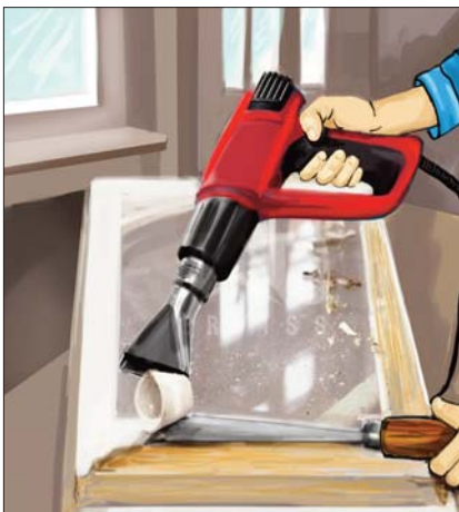
Рис. 2. Снятие старой краски строительным феном
