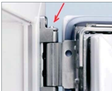
Рис. 4. Вынимание оси из петли
