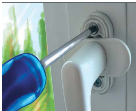
Рис. 5. Снятие ручки окна
