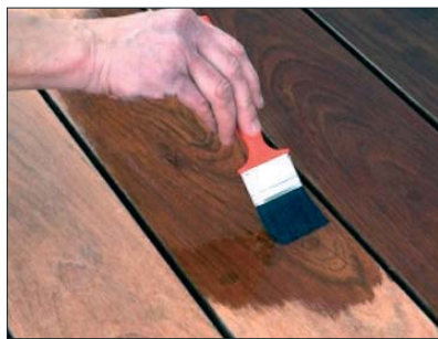
Рис. 2. Нанесение морилки на древесину
