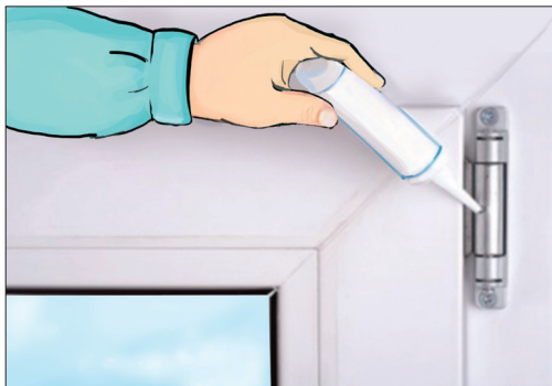
Рис. 7. Смазывание петель
