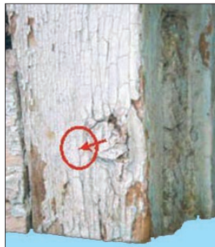
Рис. 5. Скрепление окна нагелем
