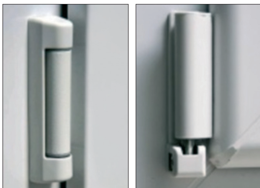
Рис. 3. Снятие декоративного колпачка с петель
