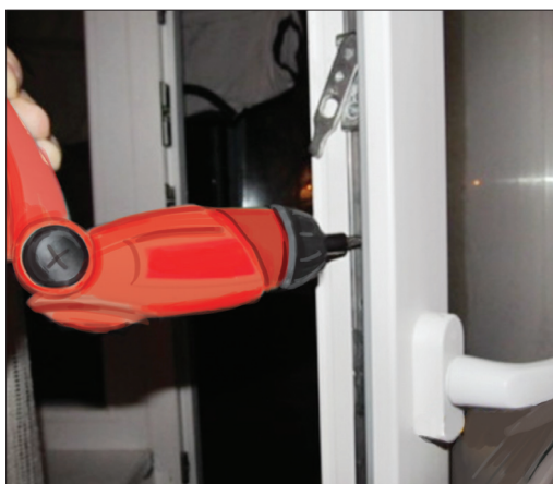
Рис. 6. Снятие фурнитуры
