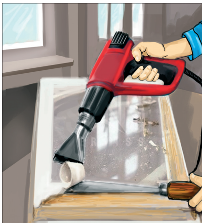
Рис. 2. Снятие старой краски строительным феном
