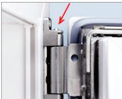
Рис. 4. Вынимание оси из петли
