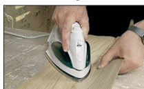
Рис. 8. Наклеивание шпона с помощью утюга
