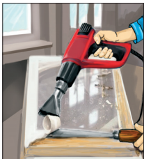
Рис. 2. Снятие старой краски строительным феном
