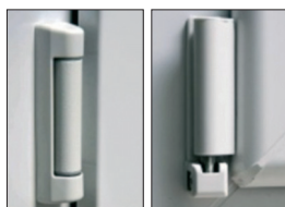
Рис. 3. Снятие декоративного колпачка с петли
