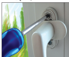
Рис. 5. Снятие ручки окна
