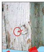
Рис. 5. Скрепление окна нагелем
