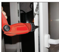
Рис. 6. Снятие фурнитуры
