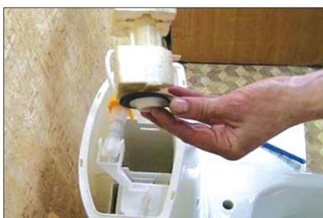
Şəkil 4. Pərdənin yenisi ilə əvəzlənməsi
