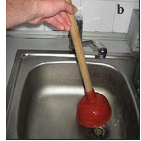
Şəkil 6. Sifonun vantuzla mexaniki təmizlənməsi: a – vantuz; b – sifonun vantuzla təmizlənməsi
