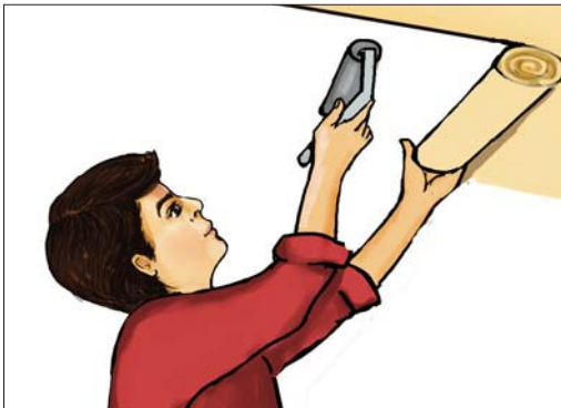
Şəkil 2. Tavana divar kağızının çəkilməsi
