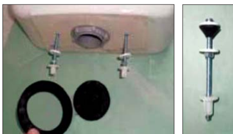
Şəkil 3. Boltların dəyişdirilməsi
