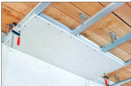
Şəkil 8. Gipskarton lövhələrin bərkidilməsi
