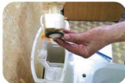
Şəkil 4. Pərdənin yenisi ilə əvəzlənməsi
