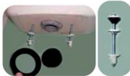
Şəkil 3. Boltların dəyişdirilməsi
