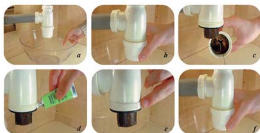
Şəkil 7. Sifonun mexaniki təmizlənmə texnologiyası
