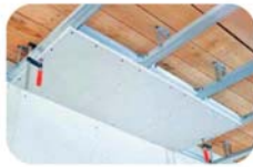
Şəkil 8. Gipskarton lövhələrin bərkidilməsi
