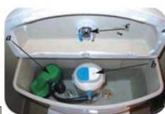
Şəkil 2. Axıdıcı çənin əsas tərkib hissələri: a – buraxıcı və doldurucu armatur; b – boşaldıcı mexanizm; c – su axıtma düyməsi
