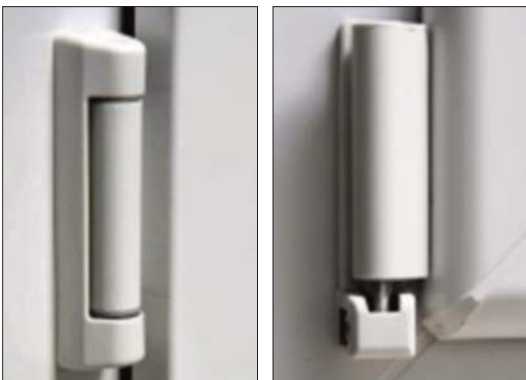
Şəkil 3. Həncamalardan dekorativ qapağın çıxarılması
