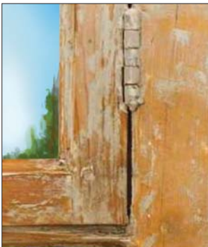
Şəkil 3. Boyası çıxarılan çərçivə
