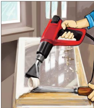
Şəkil 2. Köhnəlmiş boyanın inşaat feni ilə çıxarılması
