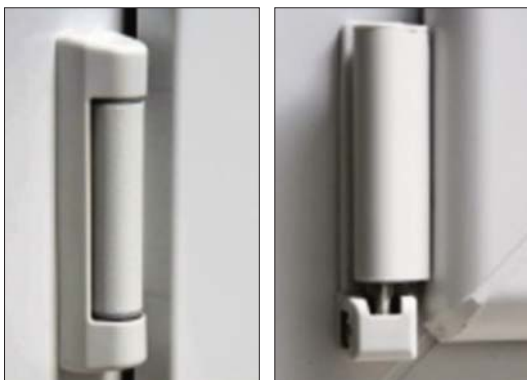
Şəkil 3. Həncamalardan dekorativ qapağın çıxarılması
