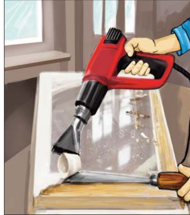
Şəkil 2. Köhnəlmiş boyanın inşaat feni ilə çıxarılması
