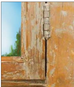
Şəkil 3. Boyası çıxarılan çərçivə
