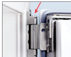
Şəkil 4. Həncamadan oxun çıxarılması
