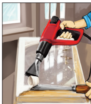
Şəkil 2. Köhnə boyanın inşaat feni ilə çıxarılması
