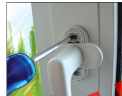
Şəkil 5. Pəncərənin dəstəyinin çıxarılması
