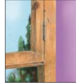
Şəkil 4. Tam təmizlənmiş pəncərə çərçivəsi
