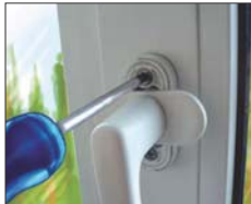
Şəkil 5. Pəncərənin dəstəyinin çıxarılması
