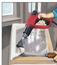
Şəkil 2. Köhnə boyanın inşaat feni ilə çıxarılması
