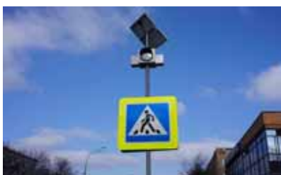
Знак пешеходного перехода, работающий на солнечных батареях.
