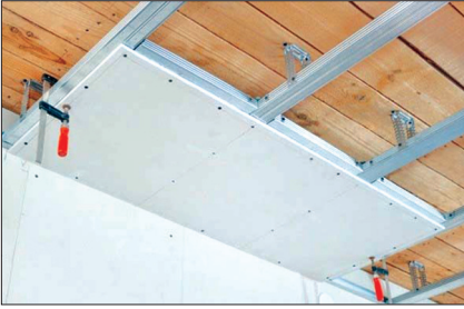
Şəkil 8. Gipskarton lövhələrin bərkidilməsi
