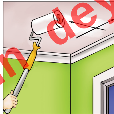
Şəkil 1. Tavanın rənglənməsi
