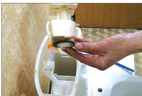
Şəkil 4. Pərdənin yenisi ilə əvəzlənməsi
