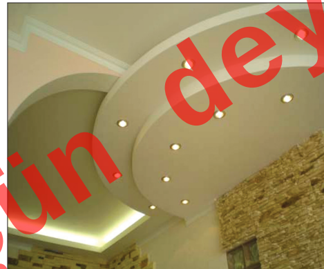
Şəkil 6. Işıqlandırması olan gipskarton lövhələrdən yığılmış asma tavan
