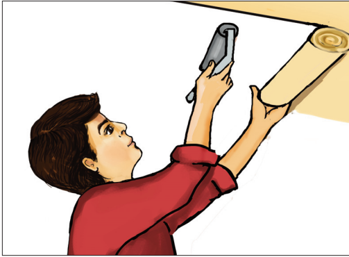
Şəkil 2. Tavana divar kağızının çəkilməsi
