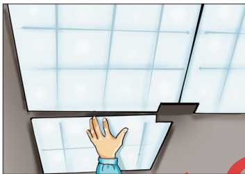
Şəkil 3. Tavana plitələrin yapışdırılması
