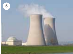
Elektrik stansiyalarının inşası
