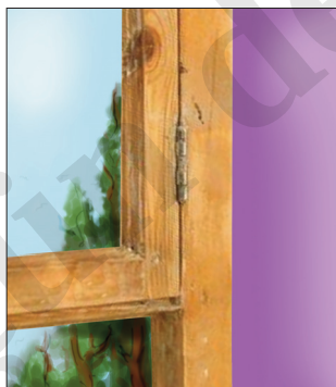
Şəkil 4. Tam təmizlənmiş pəncərə çərçivəsi
