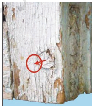
Şəkil 5. Ağac mıxla bəndlənmiş pəncərə
