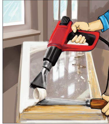
Şəkil 2. Köhnəlmiş boyanın inşaat feni ilə çıxarılması
