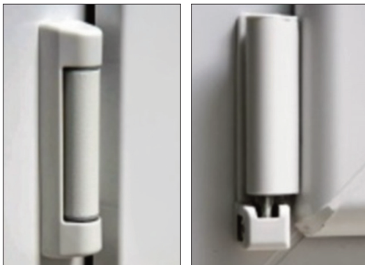
Şəkil 3. Həncamalardan dekorativ qapağın çıxarılması
