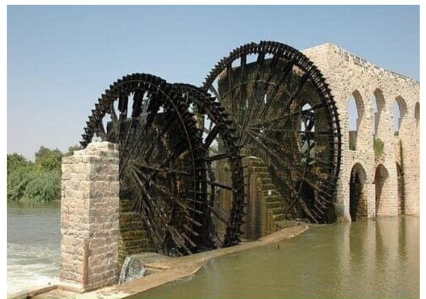
Ş. 3.9. Suyu afviduklara qaldıran “Qablı təkərlər” dəyirmanının qalıqları (Hama, Suriya).
